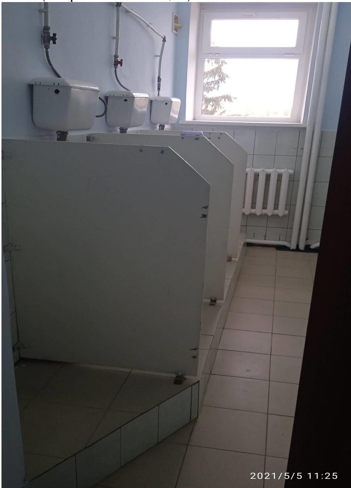
Фото №10 (санитарно-гигиенические помещения)
