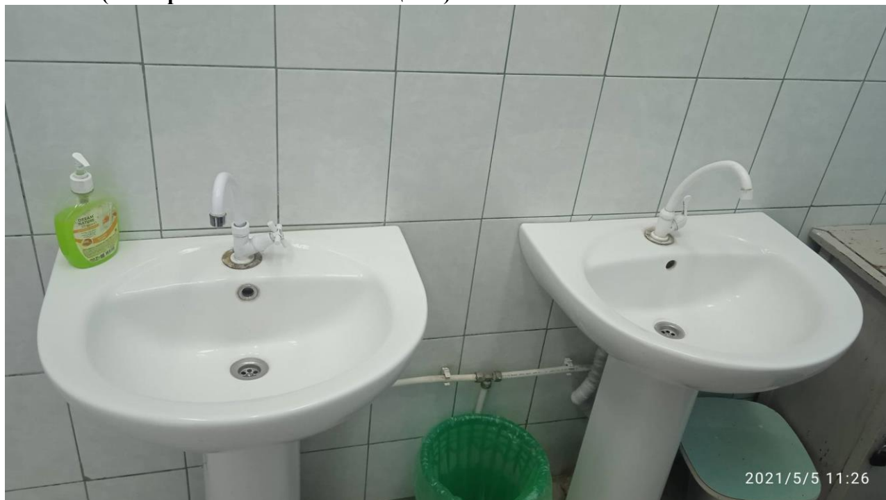
Фото №11 (санитарно-гигиенические помещения)
