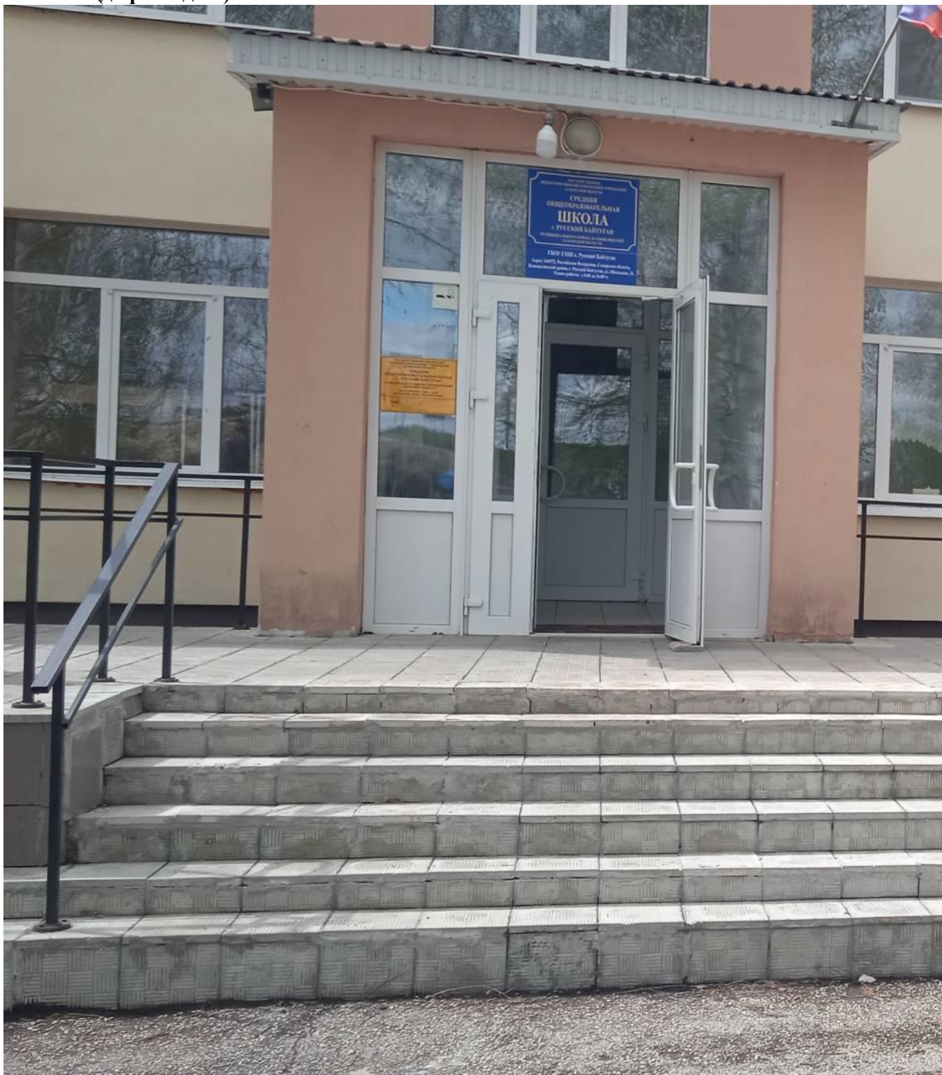
Фото №20 (дверь входная)
