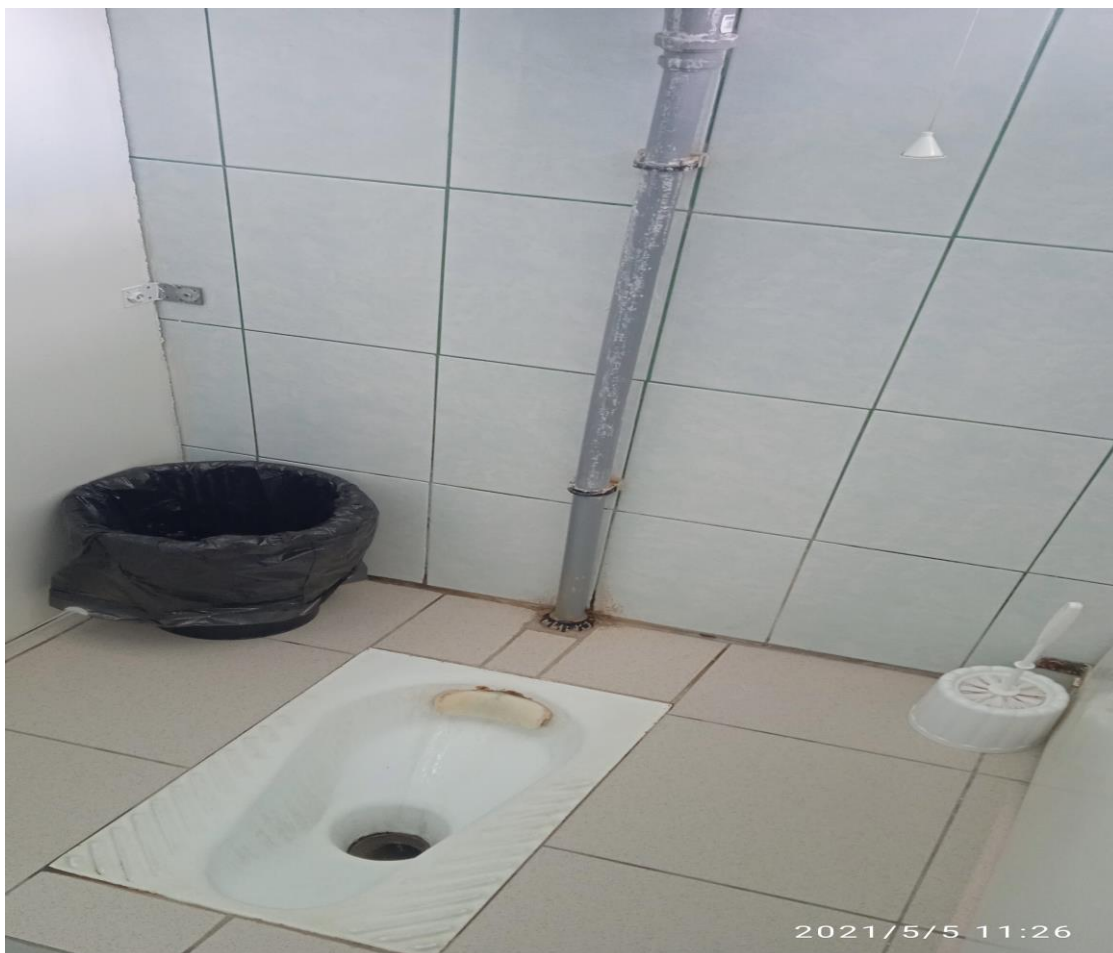
Фото №9 (санитарно-гигиенические помещения)
