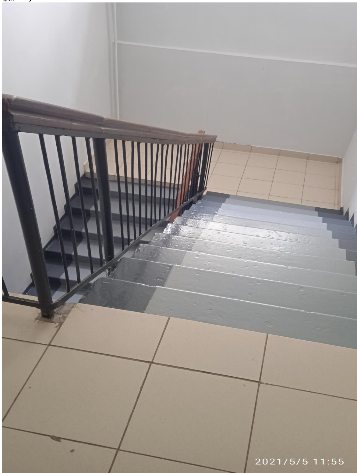
Фото №21 (лестница внутри здания)
